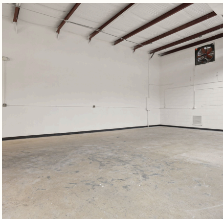
WAREHOUSE BAY — EXHAUST FAN
